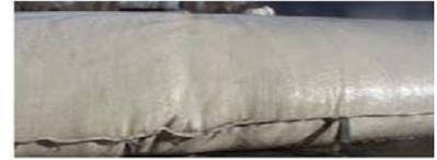
*GEO TUBE CAN RECEIVE PUMPED DREDGE YIELD FROM UP TO A MILE AWAY
